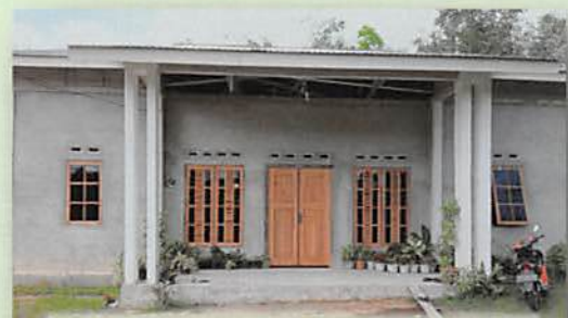
建設中のミッションハウス
