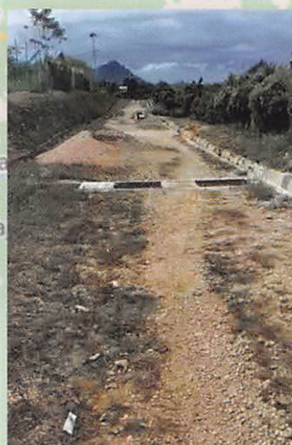
右側が増設した水路
